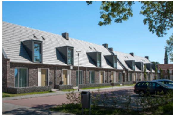
Afbeelding 8: Rijwoningen met dakkapel aan de voorzijde
