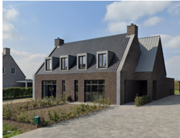
Afbeelding 6: Twee-onder-een-kapwoning met open voorgevel
