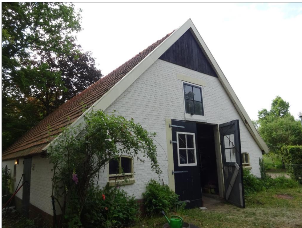
Figuur 1.2 Te renoveren schöppe gezien vanaf noordwestzijde.
