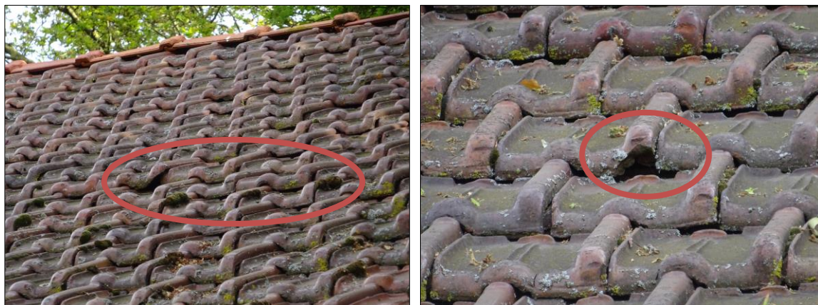
Figuur 4.1 Toegangsmogelijkheden bij het dak tot potentiële nestlocaties voor huismus (rood omlijnd).
