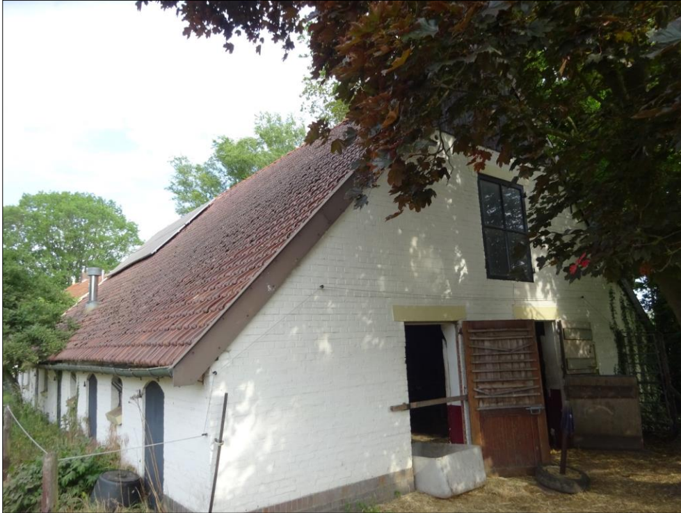
Figuur 1.3 Te renoveren schöppe gezien vanaf zuidoostzijde.
