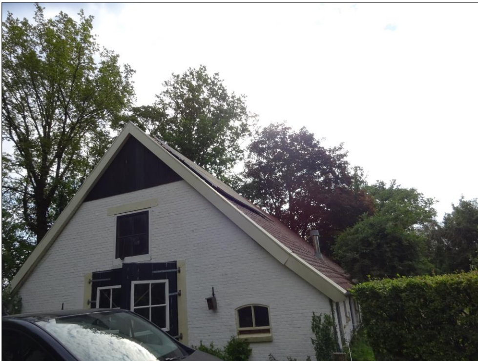
Figuur 1.4 Te renoveren schöppe gezien vanaf zuidwestzijde.
